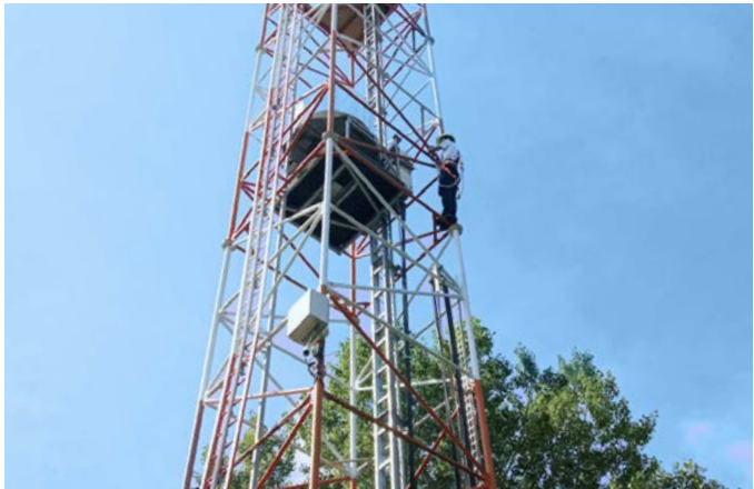
Радарная вышка | Эта 20-метровая радиолокационная вышка оснащена удобным лифтом, предназначенным для транспортировки радиолокационного оборудования между землей и вершиной вышки, что обеспечивает эффективные процессы установки и обслуживания.
